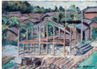
自邸Ⅲの新築現場 1914年
